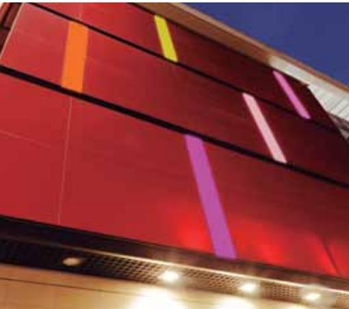
Luego de analizar con el contratista las diferentes variables, se hace una propuesta de pegado estructural con **Sikasil®SG-20**, la cual brindaba la resistencia mecánica solicitada, compatibilidad con la película del polivinilo del vidrio laminado, un excelente acabado, sencillez en la aplicación y un montaje en obra seguro.
